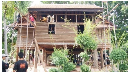
๔ สิงหาคม ๒๕๕๙ ติดตั้งยอดจั่ว ติดตั้งฝาคร่าว อุดรอยรั่วเสา และทาสีบริเวณหน้าจั่ว
