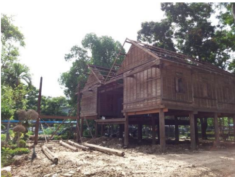
๑๘ มิถุนายน ๒๕๕๙ ตั้งเสาเรือนครัว ติดตั้งตะเหลวด้านหน้าทางเข้า
