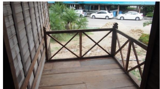
๕ สิงหาคม ๒๕๕๙ ติดตั้งไม้ปิดบริเวณช่องต่อระเบียงกลางเรือน และแต่งพื้นร้านน้ำส่วนต่อจากครัวและทำราวจับ
