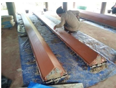
๓๑ กรกฎาคม ๒๕๕๙ ทำหลบหลังคา และทำการรัดเสา
