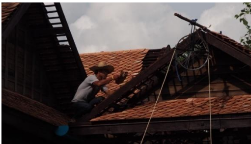
๒๗ กรกฎาคม ๒๕๕๙ มุงหลังคาคร่าว และติดตั้งฝ้าคร่าว (ด้านในเรือน)
