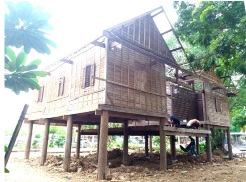
๑๘ มิถุนายน ๒๕๕๙ ตั้งเสาเรือนครัว ติดตั้งตะเหลวด้านหน้าทางเข้า
