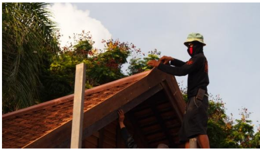
๔ สิงหาคม ๒๕๕๙ ติดตั้งยอดจั่ว ติดตั้งฝาคร่าว อุดรอยรั่วเสา และทาสีบริเวณหน้าจั่ว
