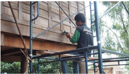
๒๘ กรกฎาคม ๒๕๕๙ แต่งไม้ฝาโดยการขยับและขัด และมีการประชุมของคณะดำเนินงานในช่วงบ่าย
