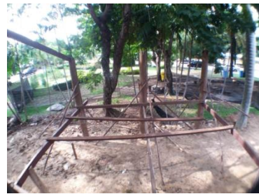
๒๒ มิถุนายน ๒๕๕๙ ติดตั้งไม้ระแนงหลังคา ไม้ตงพื้นครัว และเริ่มส่วนพื้นชานด้านหน้า
