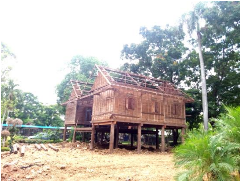
๑๗ มิถุนายน ๒๕๕๙ ไล่ไม้ระแนงหลังคา
