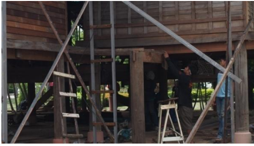
๔ สิงหาคม ๒๕๕๙ ติดตั้งยอดจั่ว ติดตั้งฝาคร่าว อุดรอยรั่วเสา และทาสีบริเวณหน้าจั่ว
