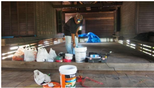
๗ สิงหาคม ๒๕๕๙ - ติดตั้งระบบไฟฟ้า
