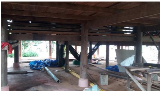
๕ สิงหาคม ๒๕๕๙ ติดตั้งไม้ปิดบริเวณช่องต่อระเบียงกลางเรือน และแต่งพื้นร้านน้ำส่วนต่อจากครัวและทำราวจับ
