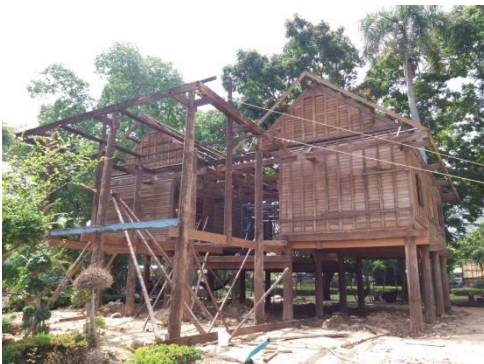
๑๙ มิถุนายน ๒๕๕๙ ตั้งเสาเรือนครัว และตั้งให้ตั้งตรง
