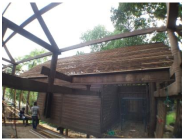
๒๒ มิถุนายน ๒๕๕๙ ติดตั้งไม้ระแนงหลังคา ไม้ตงพื้นครัว และเริ่มส่วนพื้นชานด้านหน้า
